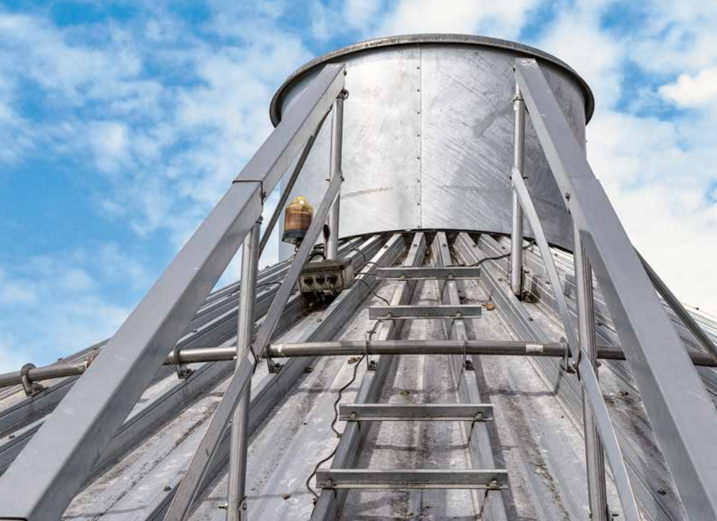
△ Neben dem Domdeckel oben auf dem Silo ist ein Sender positioniert. Er versendet die Daten der Wetterstation und der von oben ins Silo hängenden Sensorkabel. Diese messen Feuchte und Temperatur des Getreides. Die Daten lassen sich auf dem Smartphone abrufen.
